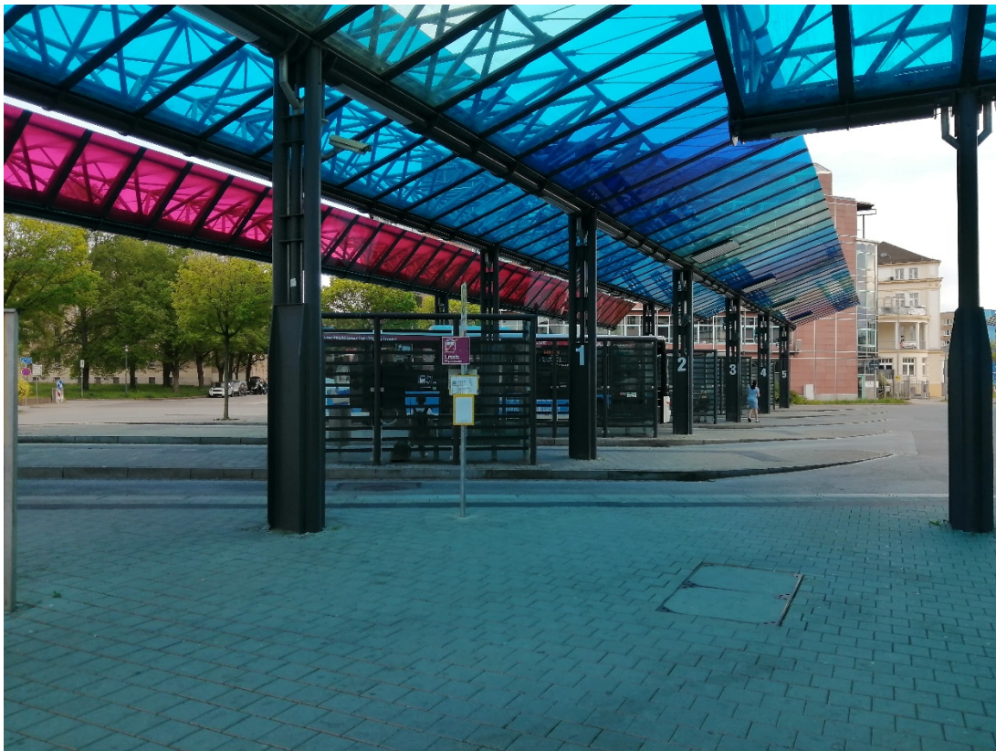
Foto 6: Der Bussteig 0 ist nicht explizit als dieser gekennzeichnet.
