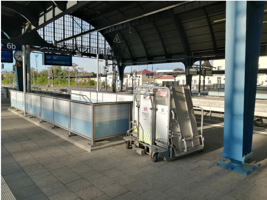
Foto 1: Alle Bahnsteige verfügen über mobile Ein-/Ausstiegshilfen.
